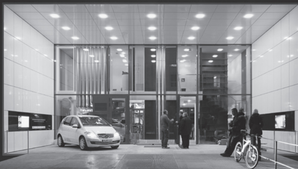
Auf der Westseite befindet sich zur Straße ein großer überdachter Vorbereich zum Parken und Tanken der Elektroautos.
